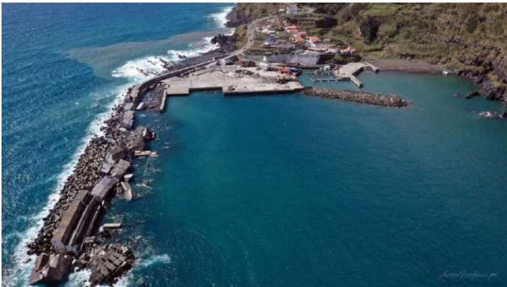
Figura 41. Porto comercial das Lajes das Flores após a passagem do Furacão Lorenzo Fonte: Portos dos Açores
