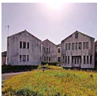
Figura 2 - Edifícios vagos com potencial de reabilitação
