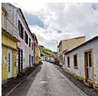
Figura 1 -Alojamentos com paredes exteriores degradadas
